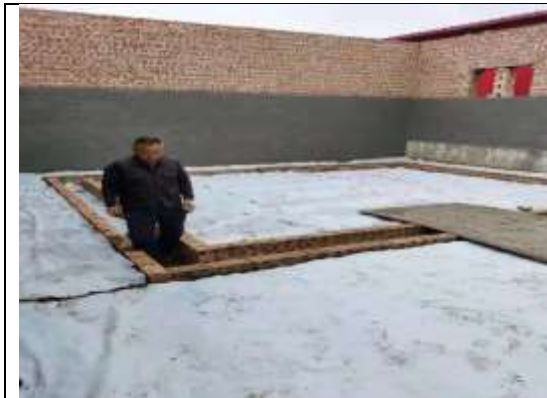
危废暂存间在建期间地面HDPE膜铺设
