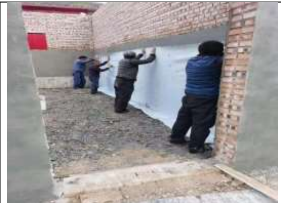
危废暂存间在建期间墙裙HDPE膜铺设
